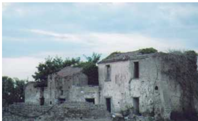
Rudere di una masseria nei pressi di Casolla Valenzana
